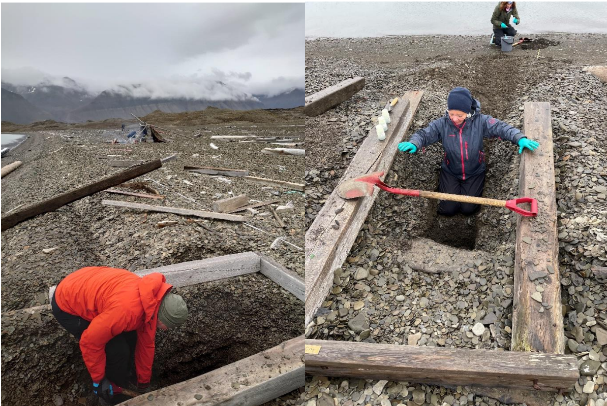
Figur 6 Forskaling rundt grøft for å hindre utrasing av steiner ved graving
