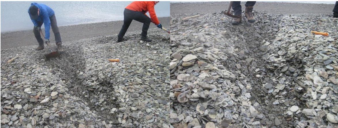
Figur 5 Graving av grøft uten forskaling
