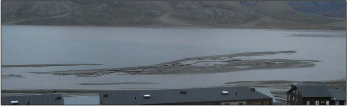
Figur 7. Tiltaksområdet under høyvann sett fra Lia i Longyearbyen. Bildet er fra august 2021 og viser den delen av området som er tørt land under normalt høyvann. Den nordlige delen av ønsket kanal er tegnet inn på bildet med tynn svart strek.
