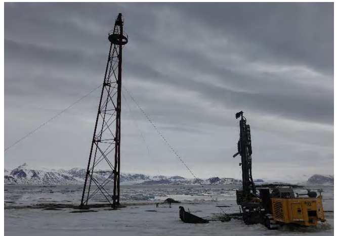
Figur 4. Pæling av fundament våren 2020 (Foto Kings Bay AS, mai 2020)
