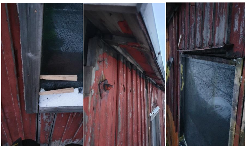
Viser kledning på østveggen under demontering.
