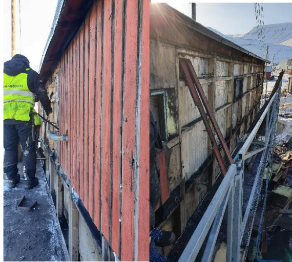
Viser kledning og bindingsverk på vestvegg under rivingen.
