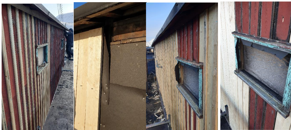
Viser remontering av gammel kledning og ny kledning på vestvegg. Detalj med remontering av vindusomramming og beslag
