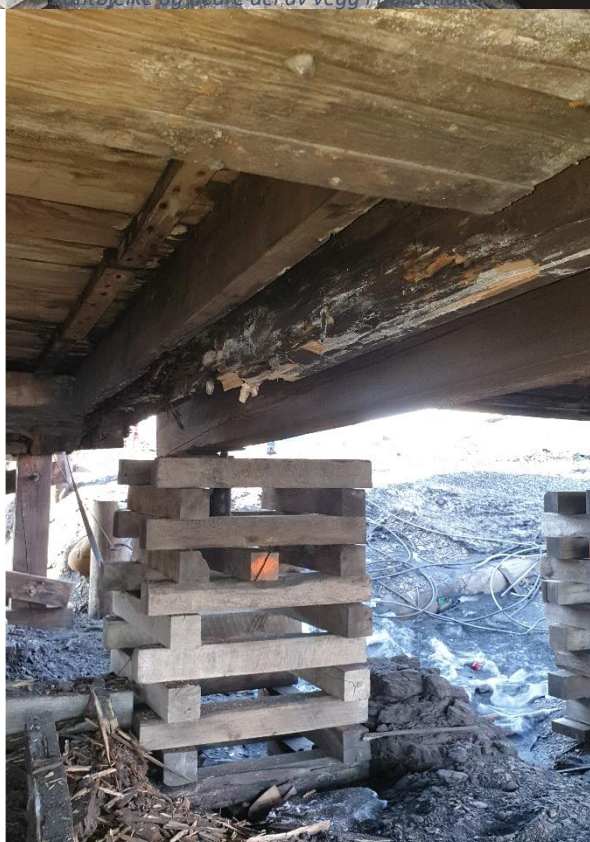
Kantbjelke under bygget.
