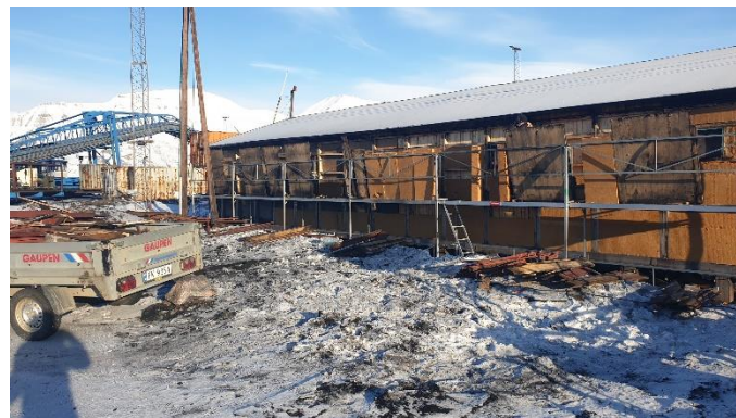
Viser isolering og montering av porøsplater på vestvegg.
