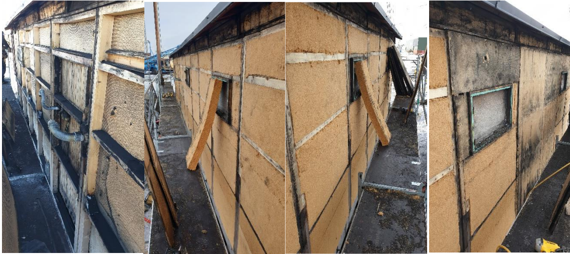
Viser isolering og montering av porøsplater på vestvegg.
