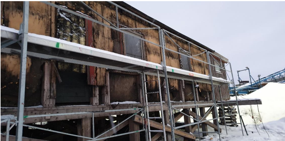
Viser østveggen etter demontering av panel. Til venstre i bildet kan man se døren som er kledd igjen.
