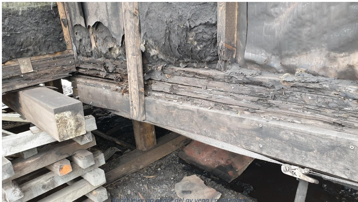
Kantbjelke og nedre del av vegg i nordenden.
