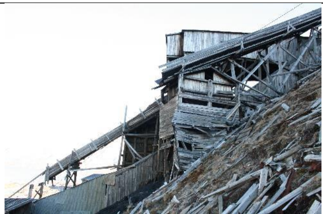
Bilde 8 Brudd i knutepunkt under plattformen ved kranen i sydlig ende på øverste nivå.
