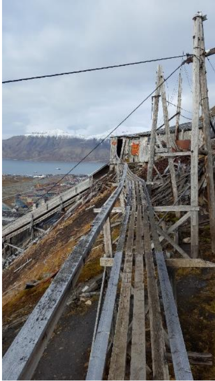
Bilde 3 Usikker gangbane i retning nordover ved øverste nivå bør forsterkes
