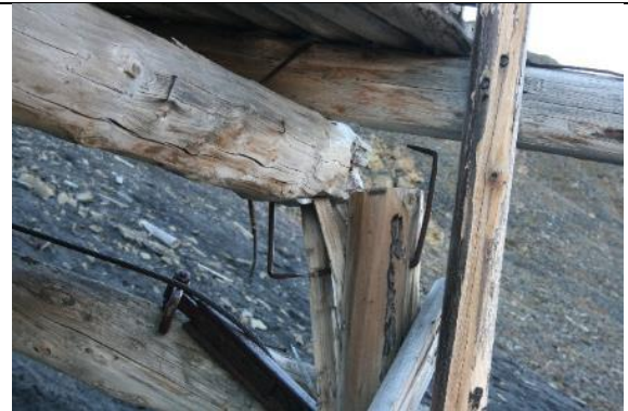
Bilde 8 Brudd i knutepunkt under plattformen ved kranen i sydlig ende på øverste nivå.
