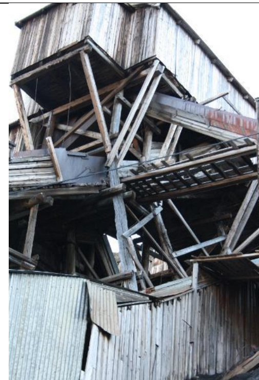
Bilde 9 Uoversiktlig statisk system med ustabile konstruksjoner.
