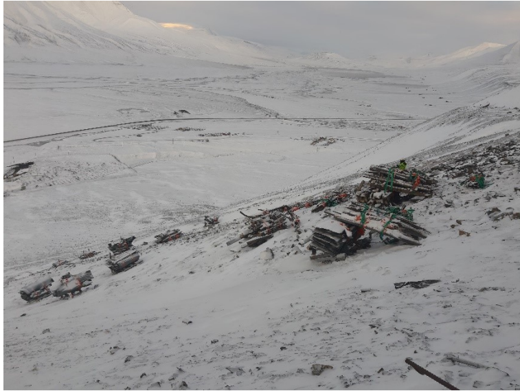
Overbygget demontert og klargjort for helikopterhiv
