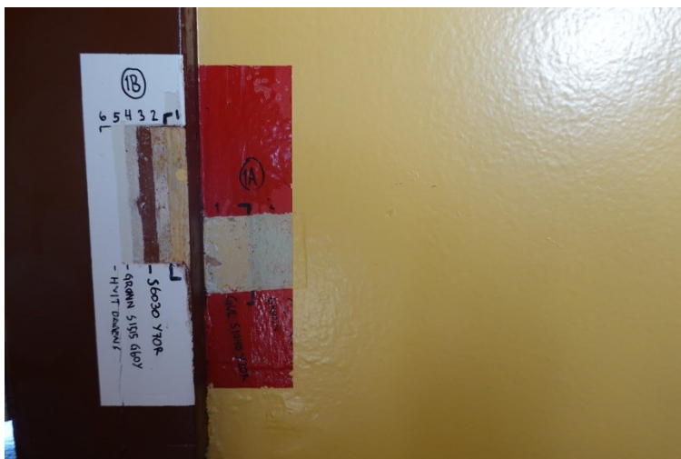
Figur 7 - Spor fra fargeundersøkelsen ble beholdt på flere steder for å vise ulike malingslag
