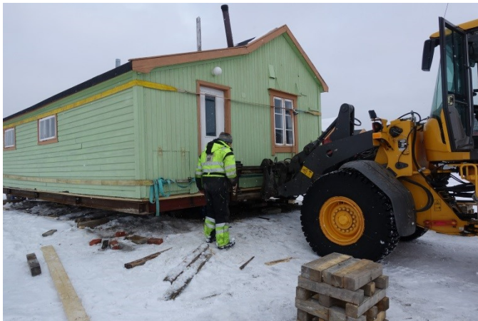
Figur 4 - Museumshytta har fått jekkestropper rundt for å holde delene sammen
