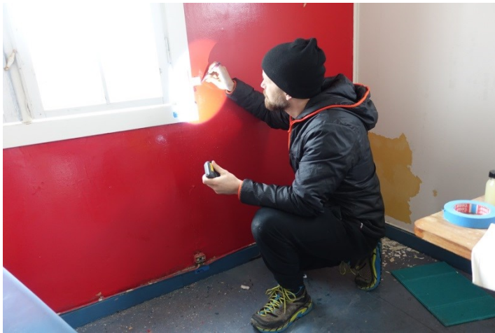
Figur 1 - Fredrik Jong fra Oslo Konserveringsatelier i arbeid med å avdekke ulike fargelag i stua
