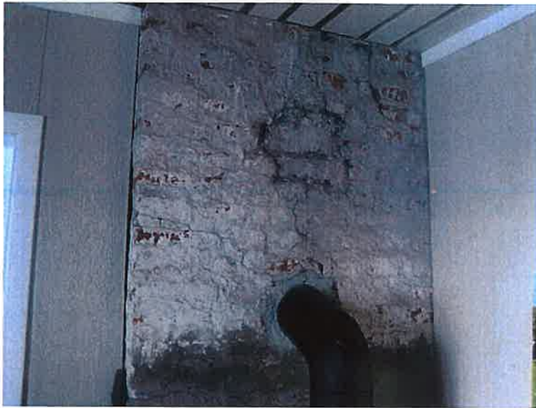
Gamal puss er fjerna, ny brannmur
