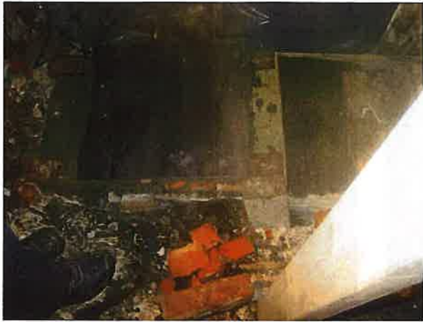
Kompakt murstein 50 cm opp frå fundamentet
