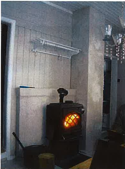
Ferdig pussa brannmur og pipe
