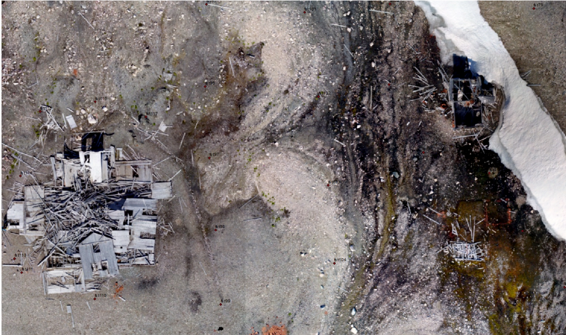
Dronebilde av stasjonen, juli 2017. Restene av bolighuset til venstre i bildet.
