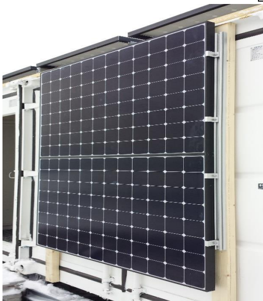
Fig 2 – paneler vegg (vertikal montert)
