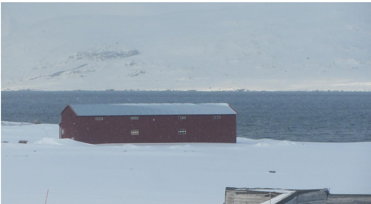
Figur 5 Bildet viser det ferdige taket på Jernlageret.
