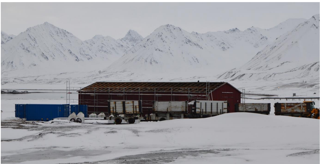
Figur 3 De gamle eternittplatene ble fjernet, og ødelagte lekter ble skiftet ut der det var behov.
