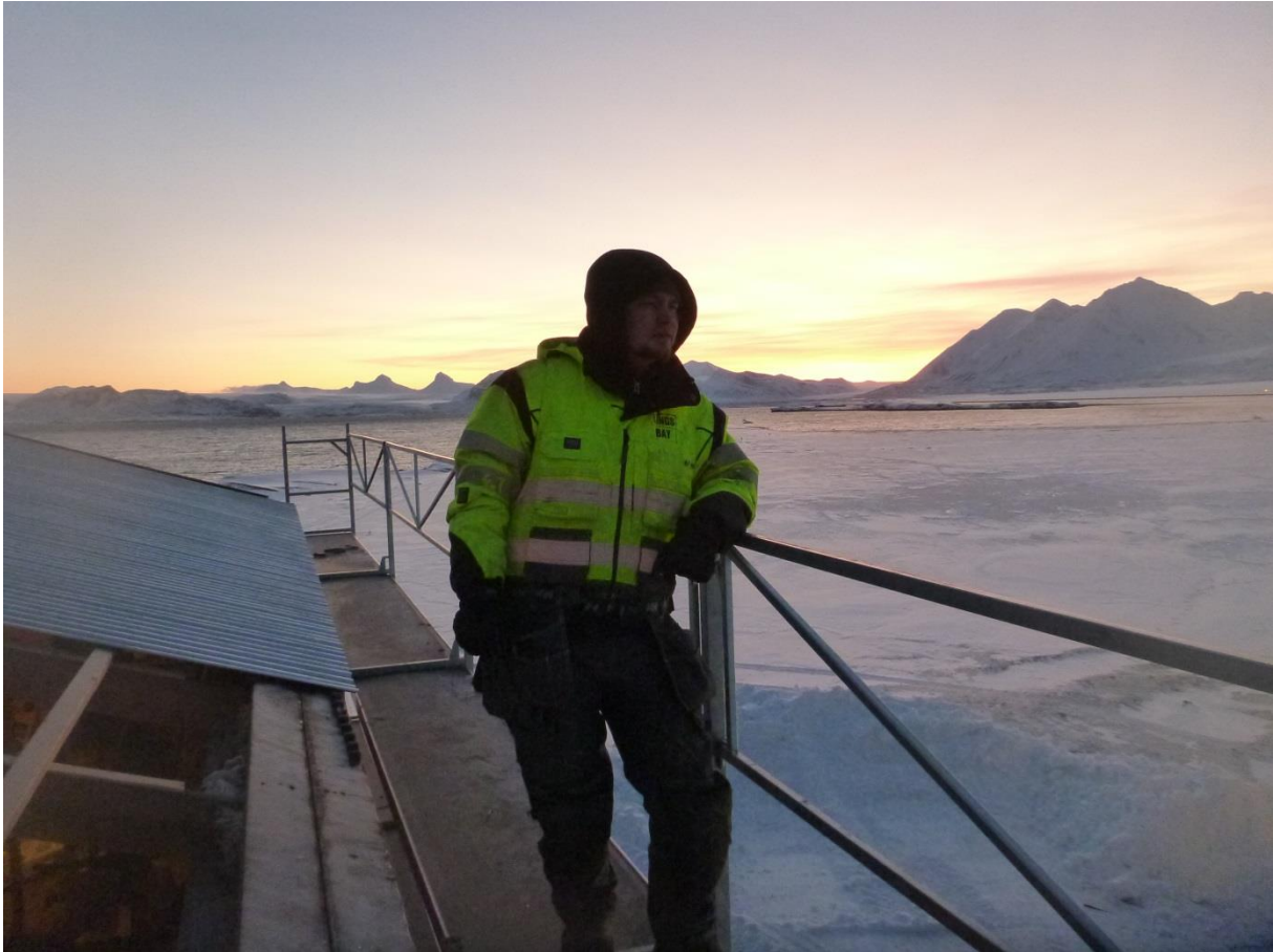
Figur 4 De gamle takplatene ble tatt av, sikret for transport til fastlandet, og nye bølgeblikkplater lagt på.
