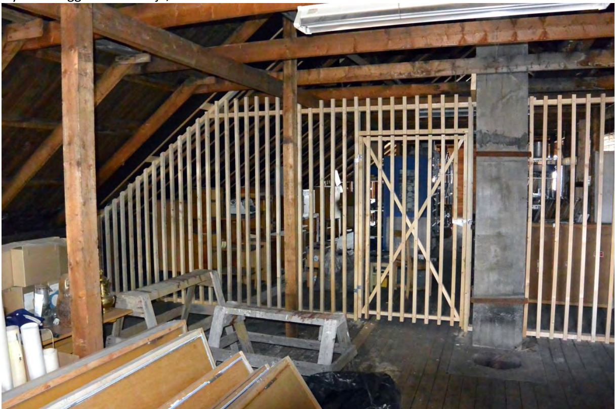
Ribbevegg i andre etasje, vestre del.
