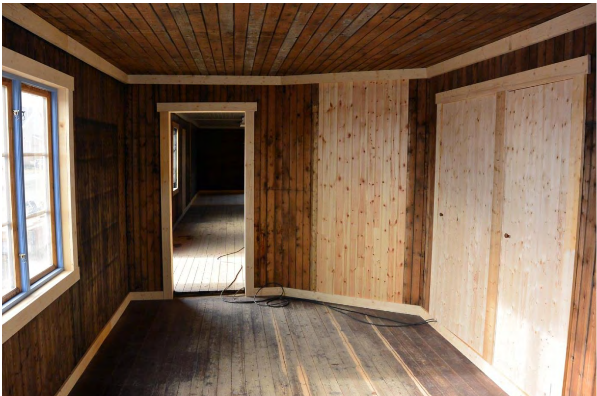
Kontorrom mot sør, med skapdører inn til data- og straumskap til høyre.
