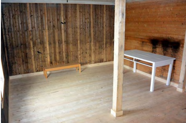
Nytt golv lagt i sørenden av bygget. Eit bor d er frest ned i skiljet frå gamalt til nytt golv for å lette reingjering.
