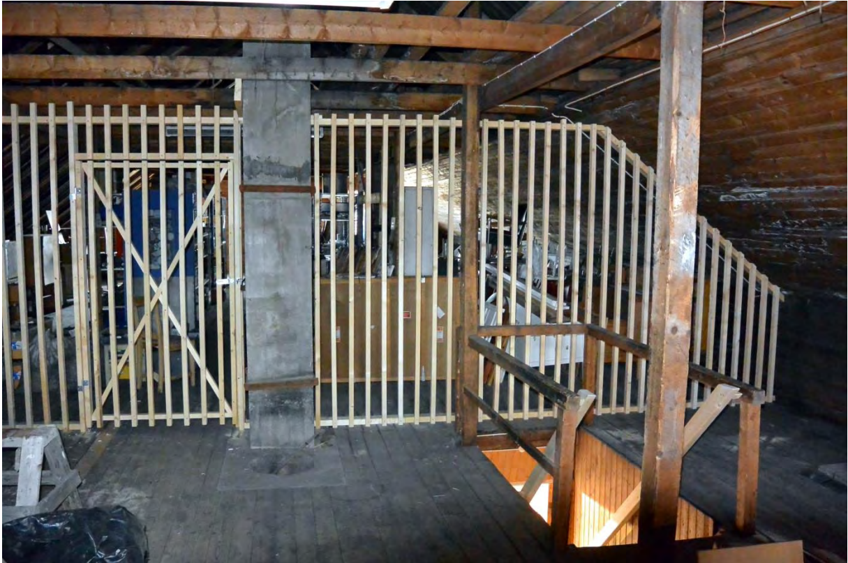
Ny ribbevegg i andre etasje, austre del.
