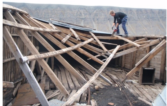
Blikkplater og taksperrer og spikerslag ble demontert for å kunne begynne på nytt. Preben kapper spikerslaget der hvor vi avsluttet rivingen.
