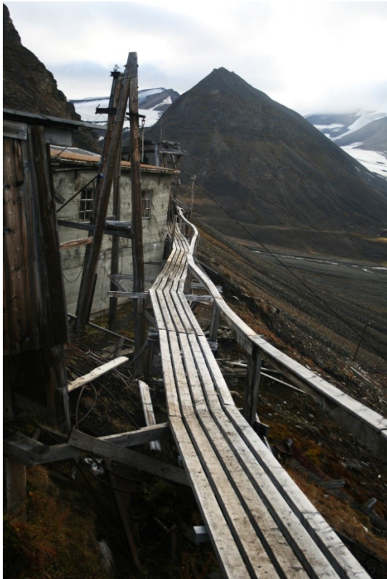
.. og etter en neve spiker.. Mest å feste på plass det som hang og slang. Noen nye bord i dekke i borte enden.
