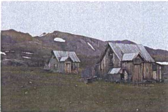
Gjenstående bygninger etter marmorbruddet i Ny-London på Blomstrandhalvøya i Kongsfjorden. Hele anlegget er automatisk fredet. Svært mange fredete bygninger på Svalbard står helt nede på bakken, ofte med en liten jordvoll opp mot ytterveggen for å beskytte mot trekk. Dette gir ofte svært kraftig fuktbelastning over sommersesongen. Foto: NIKU/Anne-Cathrine Flyen
