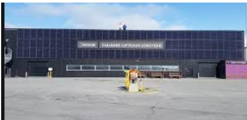
Solcelleanlegg etablert på terminalen, Svalbard lufthavn
