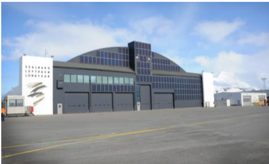
Solcelleanlegg etablert på Hangar 1, Svalbard lufthavn
